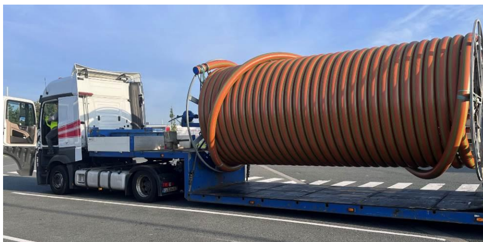
Bild 1: PE-HD Sonderrohr mit Permeationssperrschicht bei der Anlieferung einer 500 m Großtrommel
