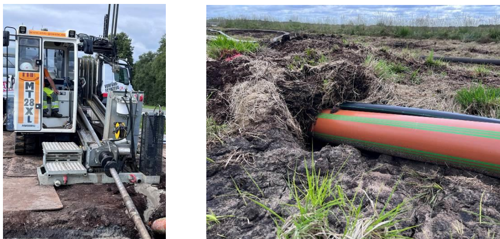
Bild 2: a) Spülbohrgerät bei der Bohrung b) Eingezogener Rohrstrang
