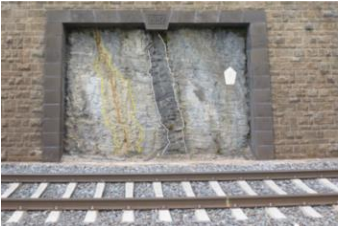
Abbildung 70: Basaltgang am Bahnhof Hirschel bei Eisenach. Der Basaltgang ist etwa 0,60 m breit und fällt steil nach Osten ein. Der Gang streicht etwa N15°E. Die Verfärbungen links und rechts des Ganges können auf Gase in Klüften zurückgeführt werden.
