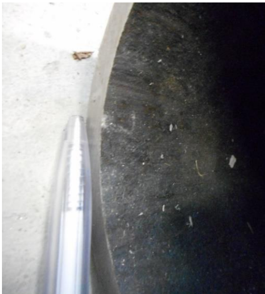
Abbildung 54: Casing 3, Innenseite unbehandelt. Die Zunderschicht auf der Innenseite ist intakt.
